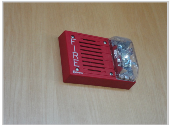
Reused fire alarm
